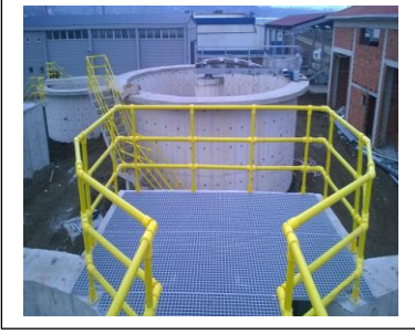
Atık ve Su Arıtma Tesisleri
